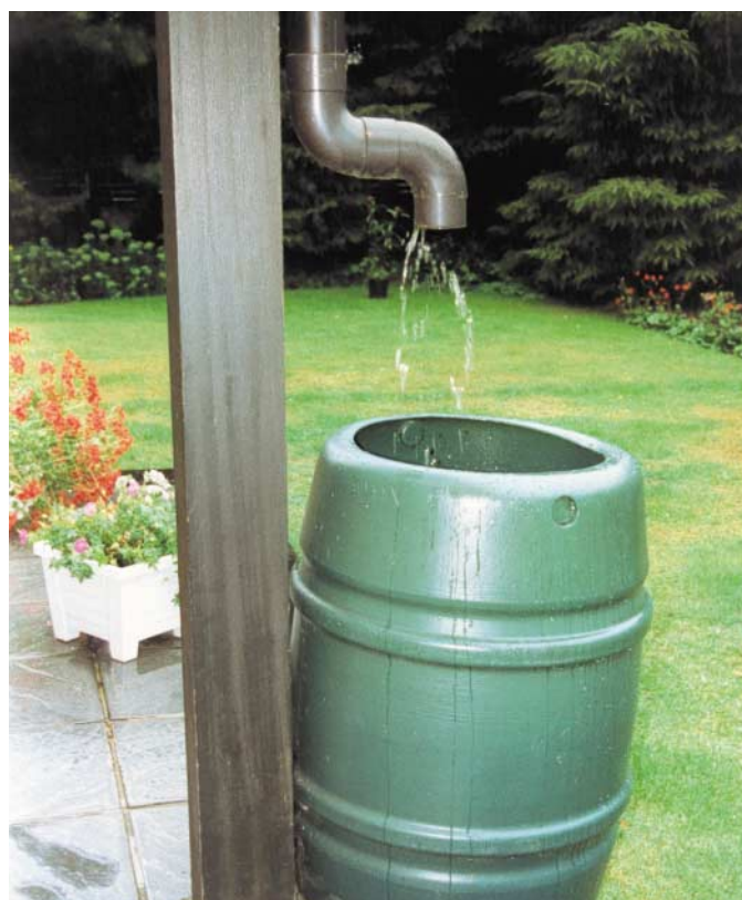
Figuur 3. Opvang van hemelwater in een ton voor de tuin en schoonmaakactiviteiten buiten.
